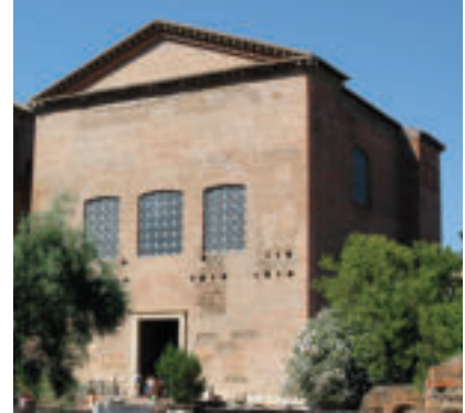
Roma senato binası
